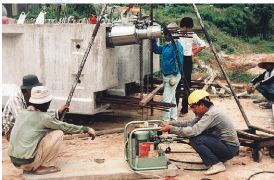
Fig. 13: Unidade hidráulica portátil e tensor multifilar para uso em pós-tensão com mobilidade
