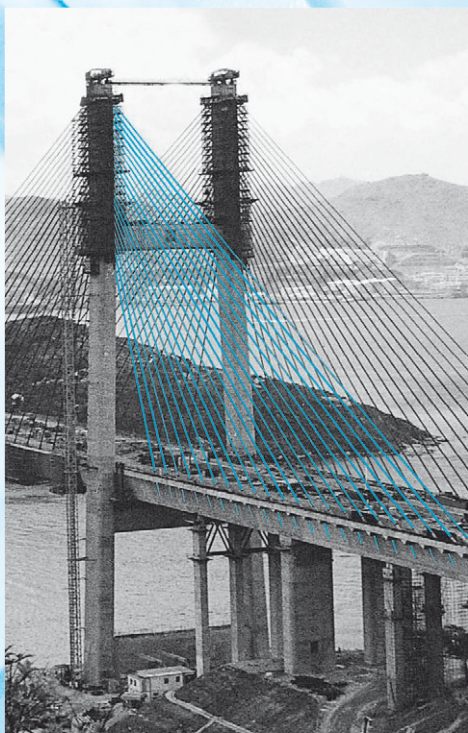
Protensão de Cabos Estaiados
