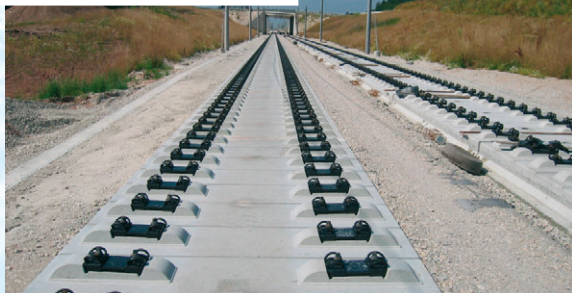
Fig. 30: blocos rígidos únicos com superestrutura direta
