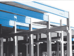
Protensão de Elementos de Concreto Pré-fabricados
