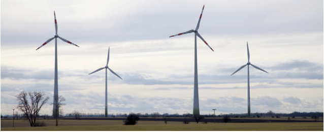
Fig. 23: Usina de energia eólica com torres de concreto protendido
