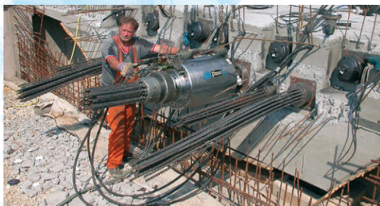
Fig. 12: Tensor multifilar TENSA M 4800 kN
